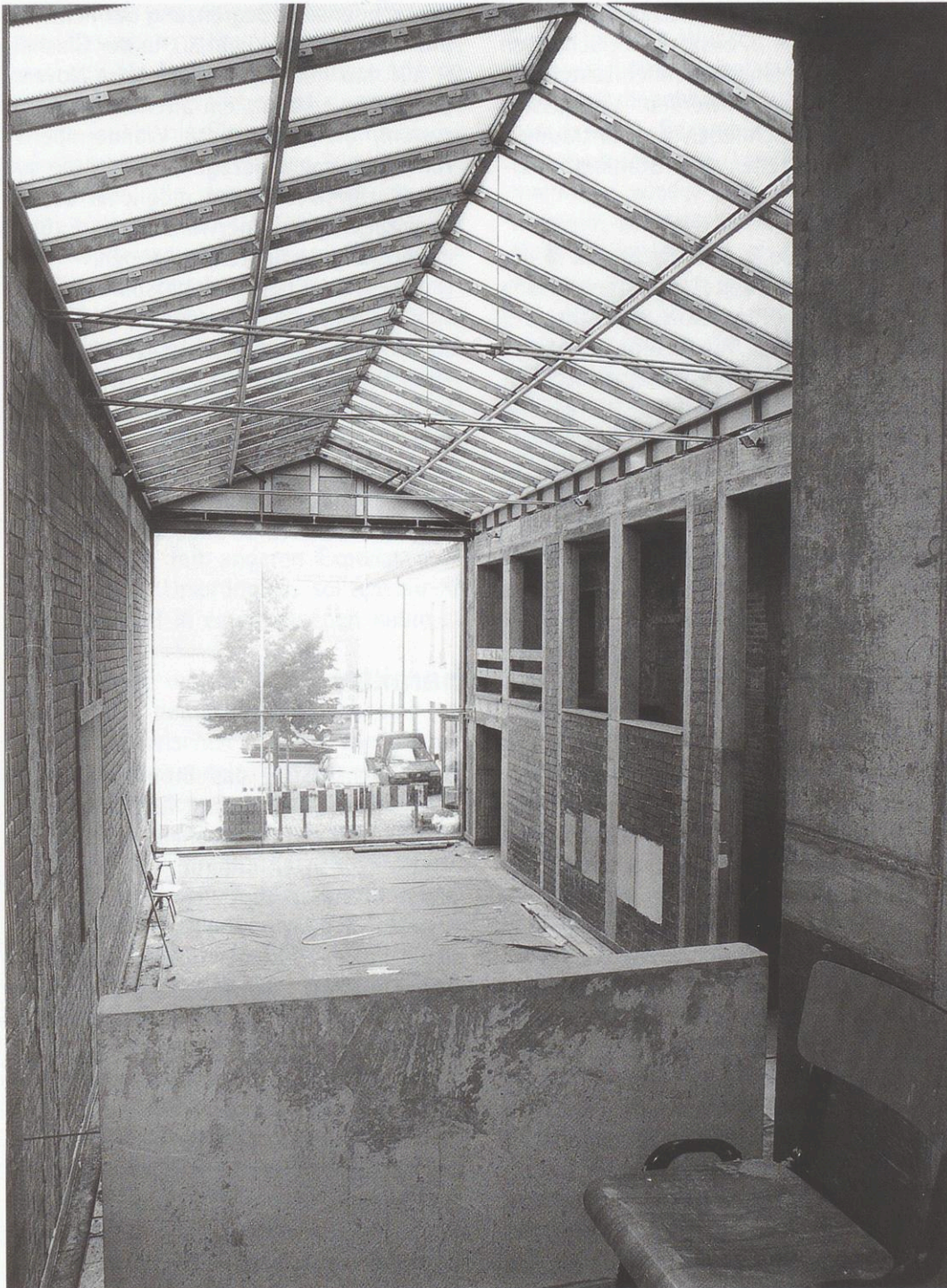
Abb. 35: Blick von der Aufzugsempore in die Glashalle nach Osten, 17. September 1999
