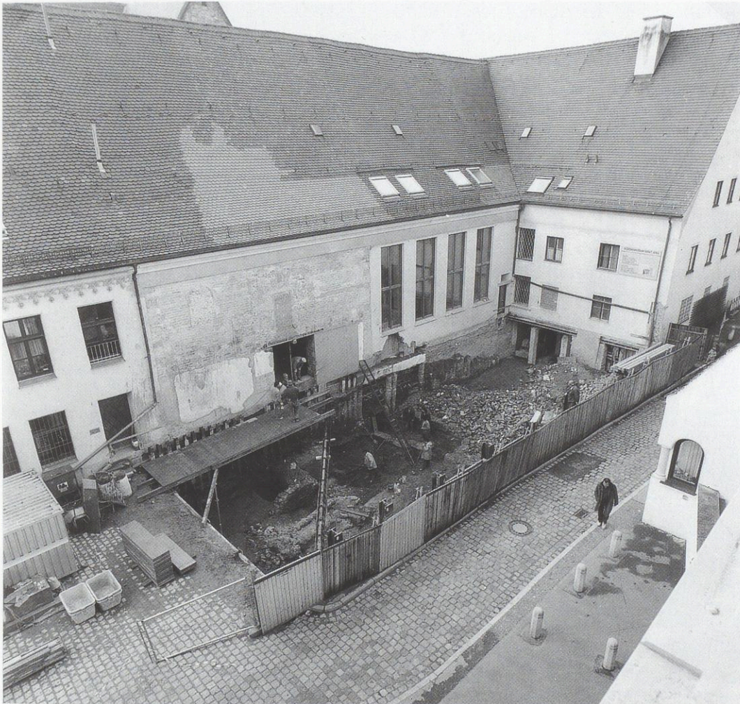
Abb. 29: Blick in die Baugrube der Glashalle, 6. April 1992
