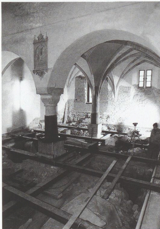
Abb. 37: Rost aus Stahlträgern über den Ausgrabungen in der Ulrichskapelle, 27. Oktober 1999
