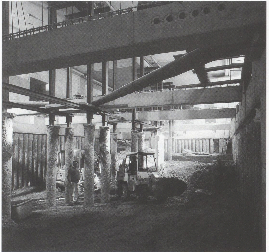
Abb. 28: Blick in die Baustelle, Raum 3, 17. Oktober 1991. Das Aushubniveau für das Kellergeschoß ist erreicht; erkennbar sind die Stahlbetonunterzüge der zukünftigen Decke sowie die provisorischen Stahlstützen
