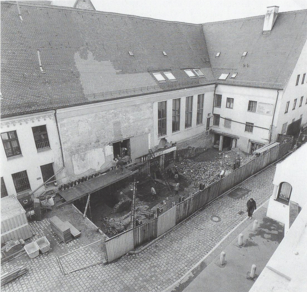
Abb. 29: Blick in die Baugrube der Glashalle, 6. April 1992
