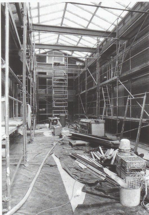
Abb. 39: Blick in die Glashalle nach Westen, Januar 2000
